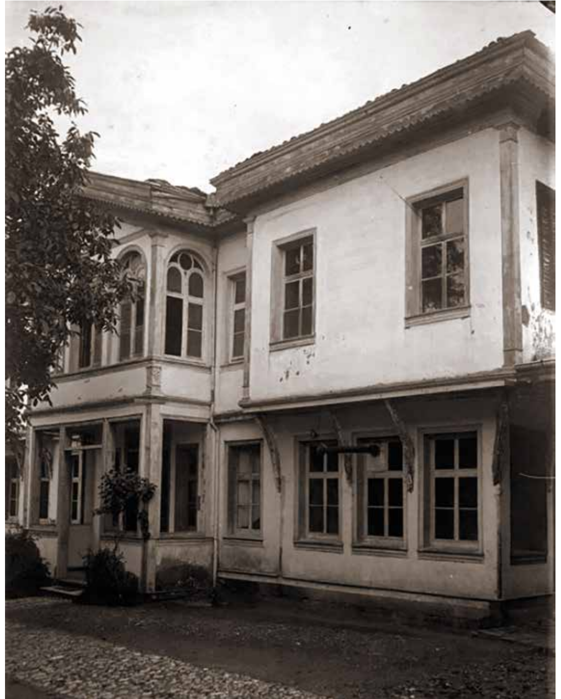
Bursa Necati Beyi Kız Enstitüsü İlk binası
